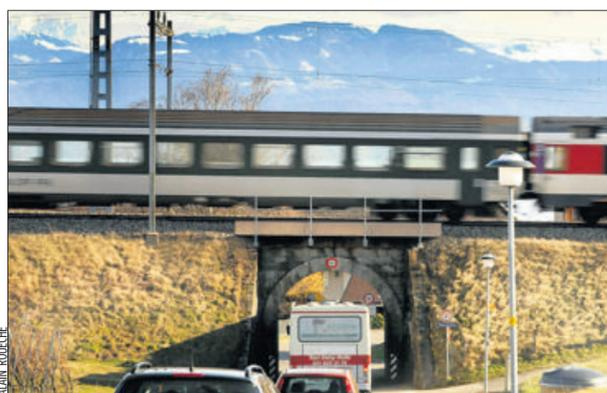
Le tunnel de Bellefontaine passera de 4,2 m à 7,5 m de large, avec un trottoir de 1,5 m. Il mesurera 4,5 m de haut.
